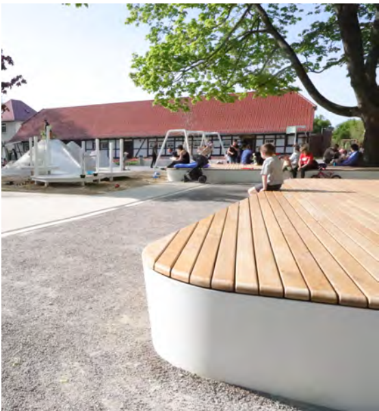
Betonové platforma s dřevěným sedákem
