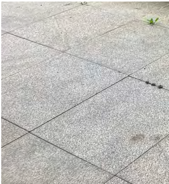
žulová dlažba velkoformát - původní dlažba
